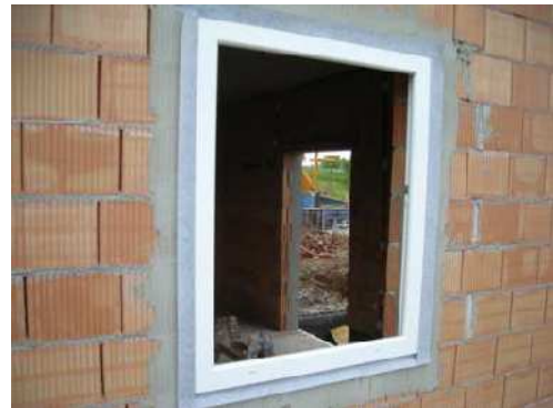
Abdichtung AUSSEN mit Terofol Ü sd 1 SK
